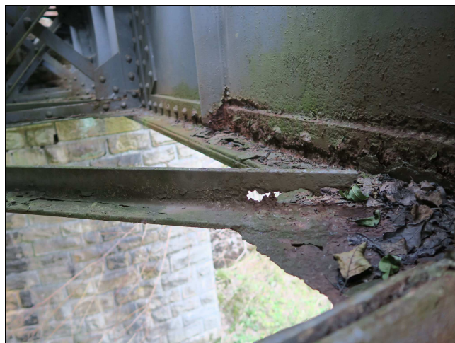
Foto č. 6 - K 01, prokorodované podélné ztužení v poli č. 03.
