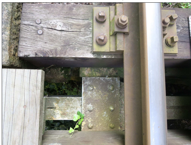
Foto č. 1 - K 01 levý hlavní nosník zapřený do závěrné zdi na O 02
