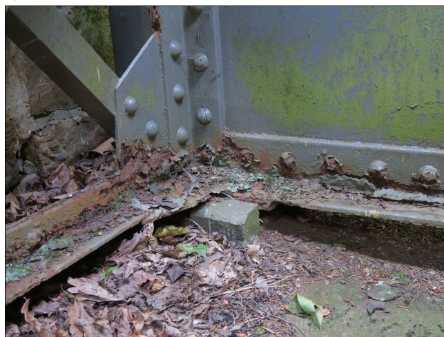
Foto č. 2 - K 01 pravý hlavní nosník koroze dolních vnitřních pasových úhelníků
