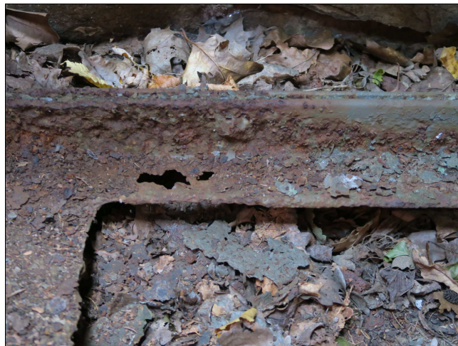
Foto č. 4 - K 01, prokorodovaný dolní úhelník příčného ztužení č. 7
