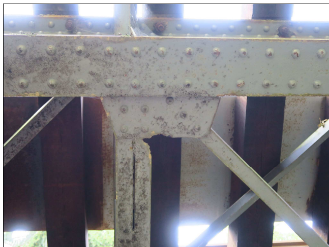
Foto č. 3 - K 01, vodorovná příruba příčného ztužení č. 5 vlevo zkorodovaná do hl. až 30 mm.
