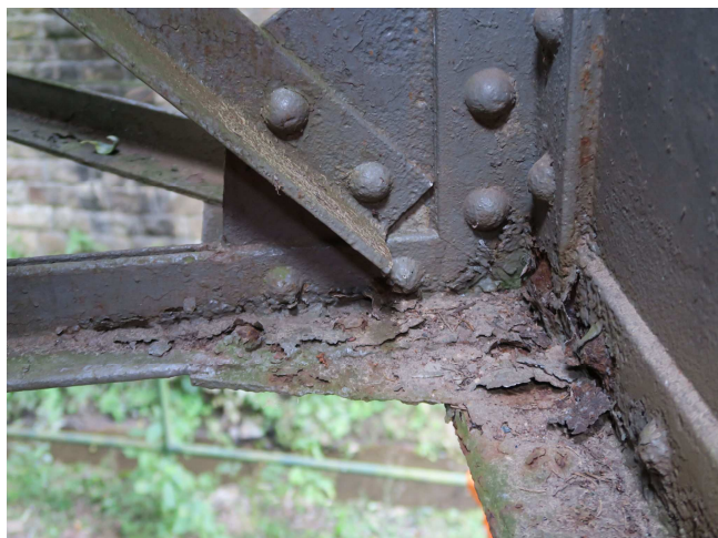
Foto č. 5 - K 01, ztužení č. 06 u levého nosníku oslabené korozi a zanesení nečistotami
